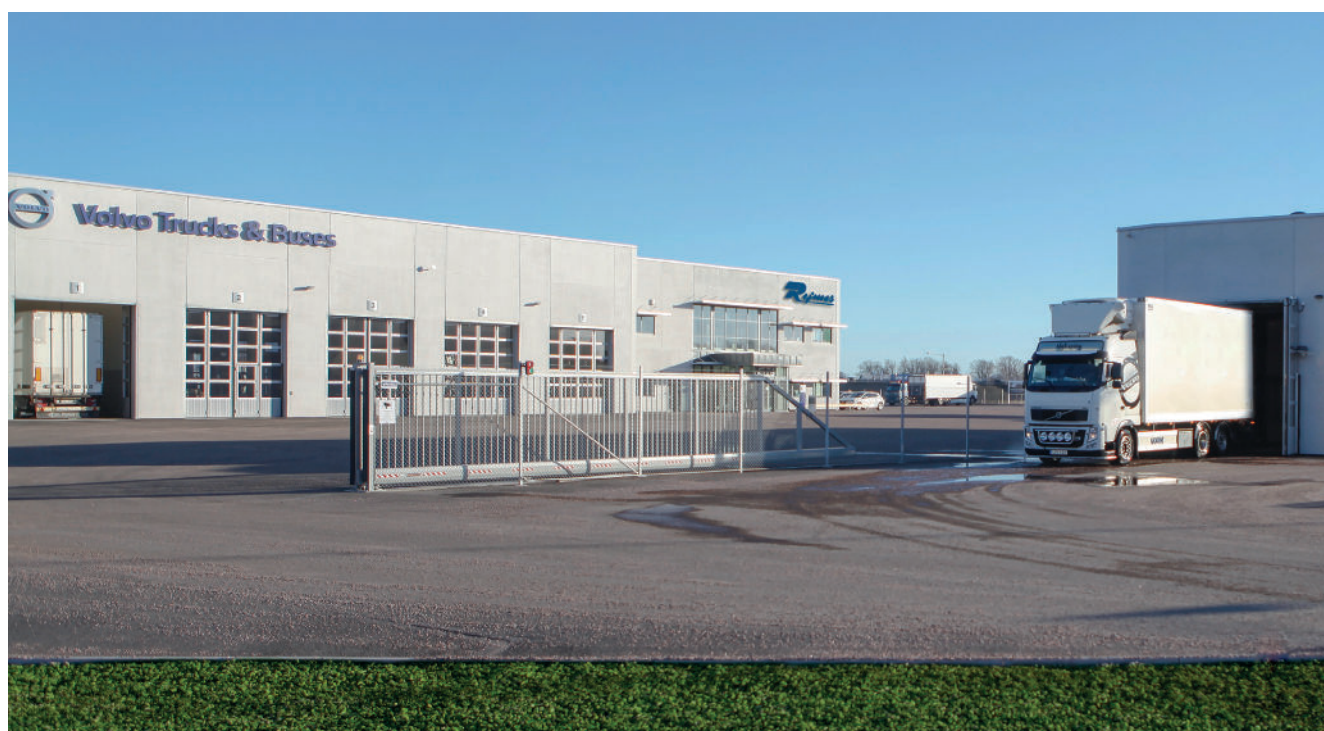
Nya lastvagnsanläggningen i Nyköping.
